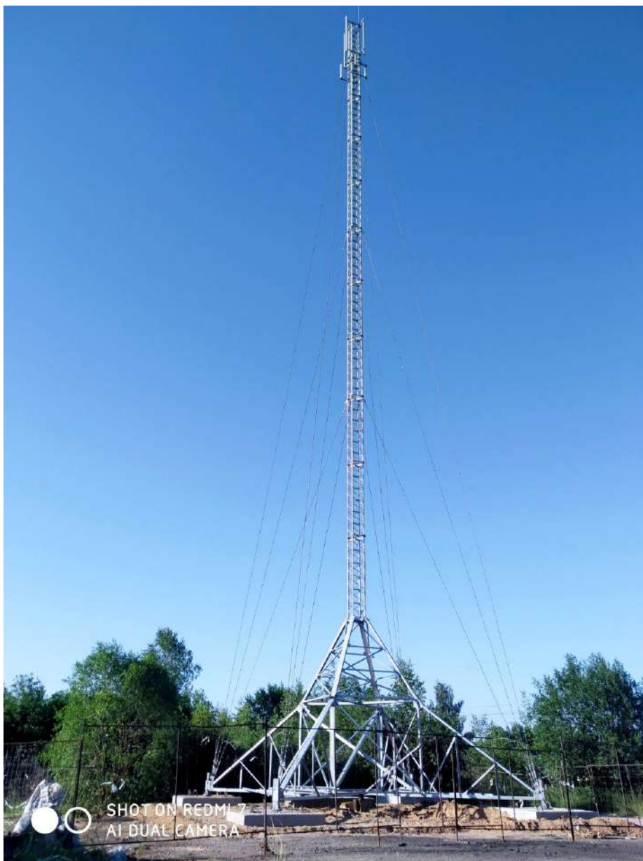
Рисунок 6 – Внешний вид металлоконструкций мачты высотой 39 м (объект-аналог)
